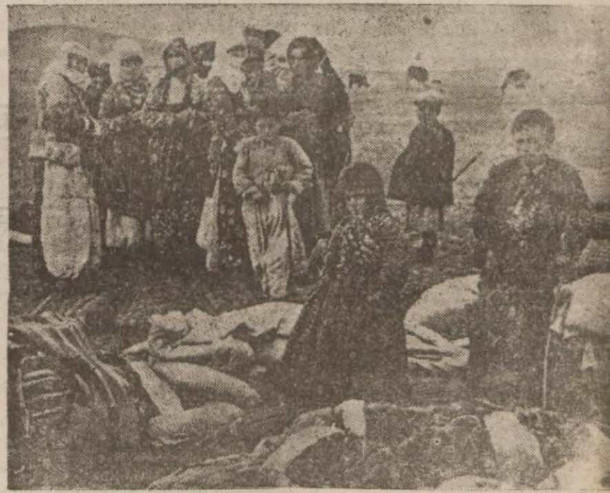
Zelzelenin tahribatı geçtikten sonra yıkılan binaların etrafında taharriyat yapan köylüler
